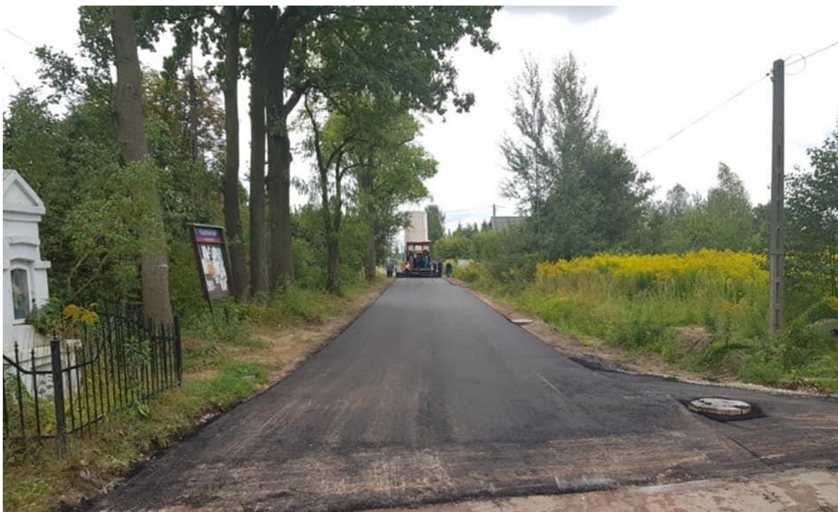
Fotografia 42. Wykonanie nakładki asfaltowej na ulicy Różanej w Kazimierowie (od ul. Polnej do ul. Zastawie) po zakończeniu budowy kanalizacji sanitarnej.
