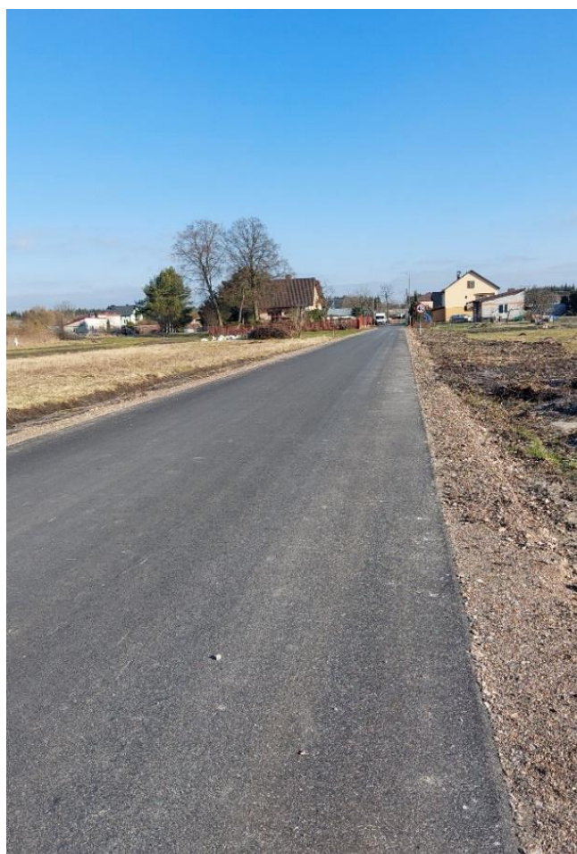
Fot. 201. Nowa nakładka asfaltowa na drodze z Michałowa do Chobotu
