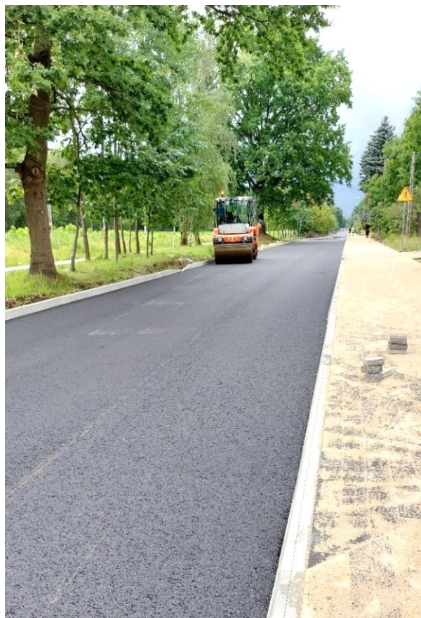
Fot. 203. Nowa nakładka asfaltowa i chodnik ul. Bema w Halinowie – II etap przebudowy
